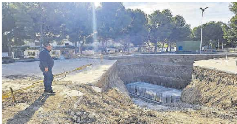
El alcalde de Los Alcázares visita las obras de mejora del sistema de saneamiento.
